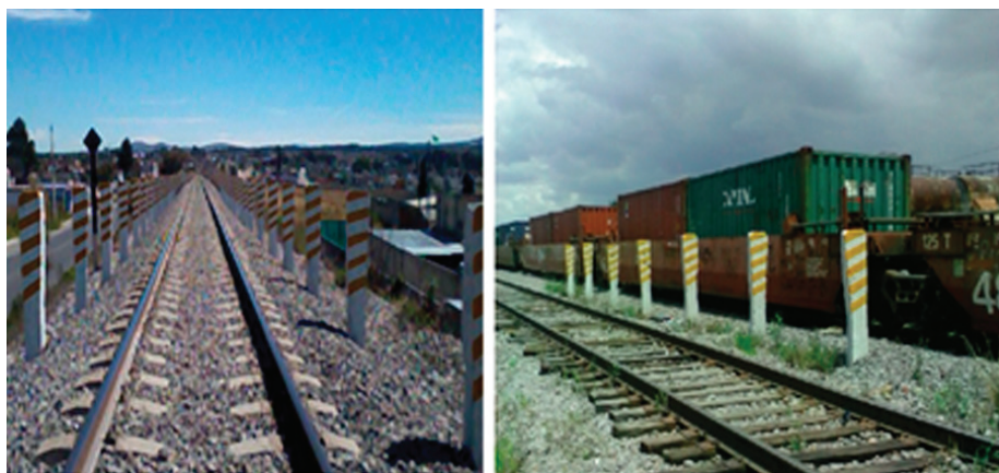
IMAGEN 2 DOS PERSPECTIVAS DISTINTAS DE LAS VALLAS COLOCADAS POR FERROSUR EN LA ESTACIÓN DE APIZACO
